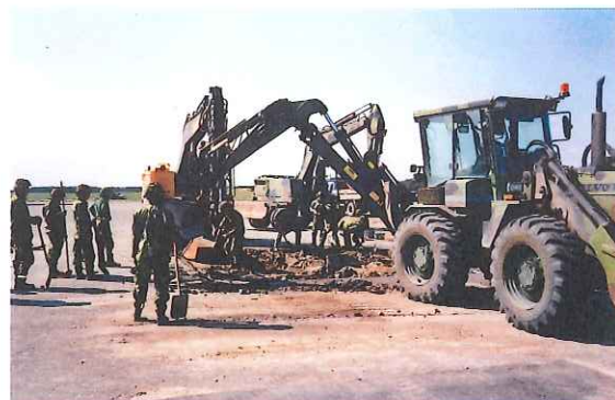
Banreparationsövning på Rinkaby flygfält
