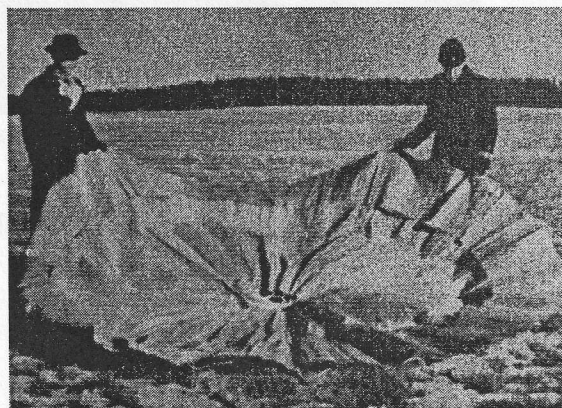
Nissafors pappersfallskärmar som togs fram under kriget visade sig fylla ett verkligt behov. De bar en last upp till 60 kg.
